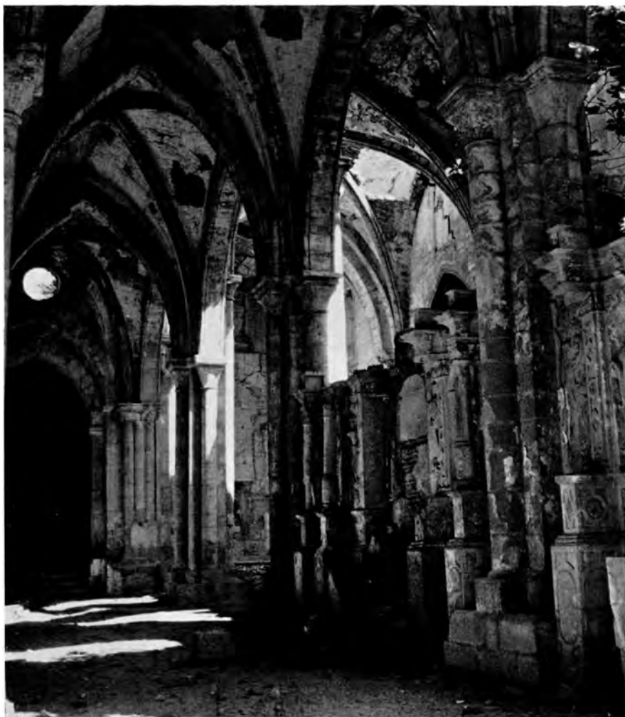
9. Nave del Evangelio de Rueda
