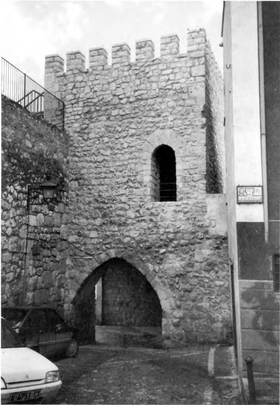
Figura 6. Portal de Daroca visto desde el interior.
